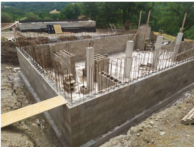
Fundamente und Kellerwand
