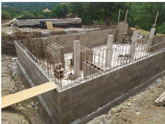
Fondazioni e muro del seminterrato
