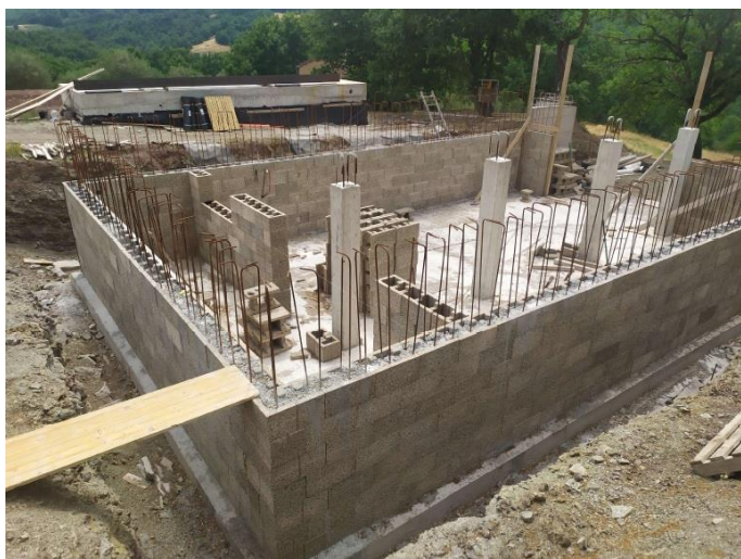
Fondazioni e muro del seminterrato
